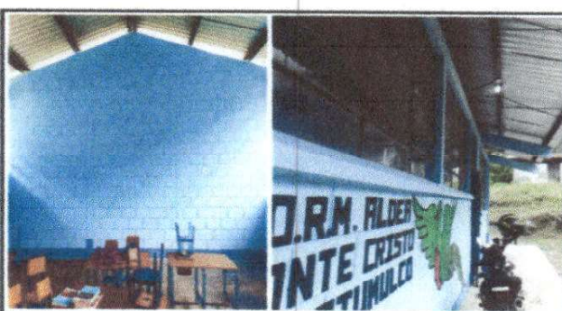
Foto 6: Mantenimiento a estructura (Pintura en muros exteriores e interiores) (modulo de aulas)
