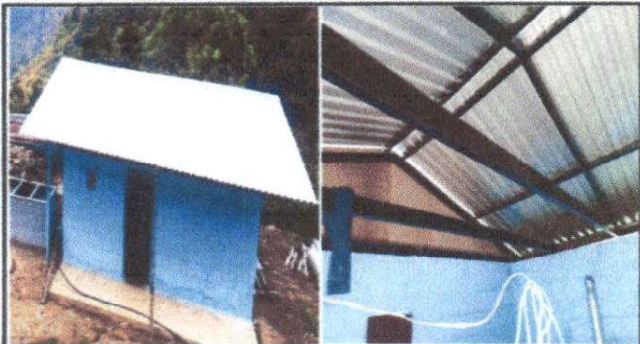
Foto 7: Mantenimiento a estructura (Pintura en muros exteriores e interiores) (modulo de cocina)
