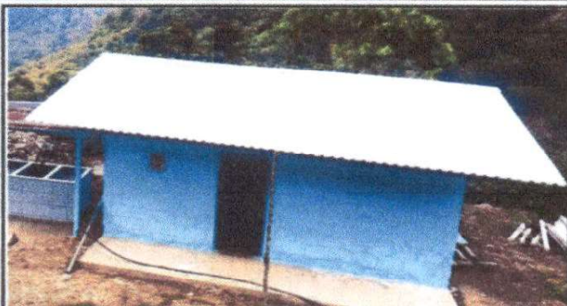
Foto1: Sustitución de lámina por lámina troquelada aluzinc calibre 26 (modulo de cocina)
