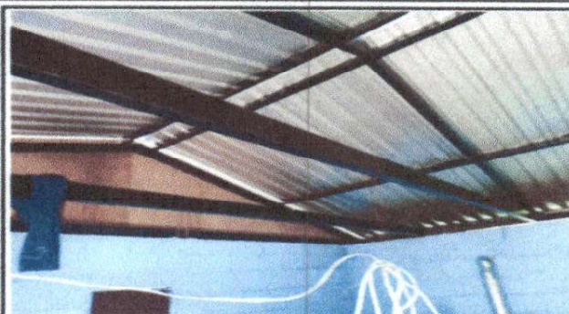
Foto 2: Sustitución de estructura de soporte de madera por metal (modulo de cocina)
