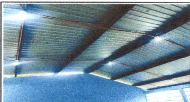
Foto 3: Reparación de sistema eléctrico (modulo de aulas)
